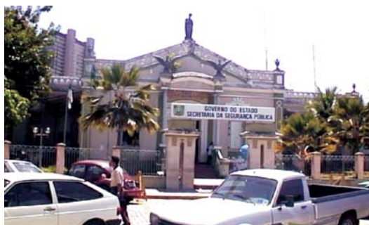
Figura R15 - Antigo prédio do Grupo Escolar Augusto Severo. Inaugurado em 12 de junho de 1908, o Grupo Escolar Augusto Severo foi o primeiro construído no Estado, sob o novo modelo educacional preconizado no início do século XX. Suas instalações abrigaram, de 1952 a 1954, o antigo Atheneu Norte-Riograndense e, de 1956 a 1973, a Faculdade de Direito de Natal.
