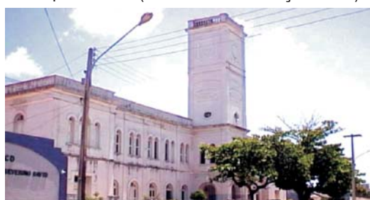
Figura N4 - Antigo Escritório da Estrada de Ferro. O prédio está localizado na Esplanada Silva Jardim, no bairro Rocas. Sua inauguração ocorreu no início do século XX para abrigar os escritórios da E. F. Central do RN e contou com a presença do então presidente da República, Afonso Pena. Em 1968 o escritório foi desativado e, posteriormente, foi transformado em escola.
