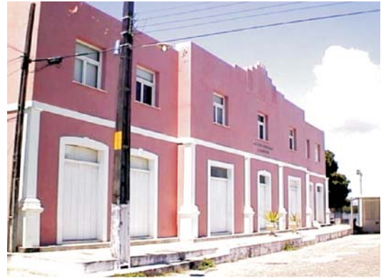
Figura R20 - Centro de Treinamento e Museu Ferroviário. Construído no início do século XX, esta edificação abrigava os escritórios da antiga Estrada de Ferro do Rio Grande do Norte. A partir de 1966, o prédio foi restaurado para suas novas funções, preservando suas linhas arquitetônicas originais.
