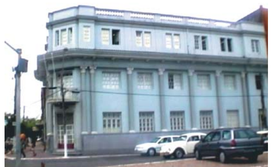
Figura R12 - Antiga sede do BANDERN - Banco do Estado do Rio Grande do Norte. Inaugurado em 1939, o prédio apresenta características arquitetônicas que o distingue no cenário urbano da capital.
