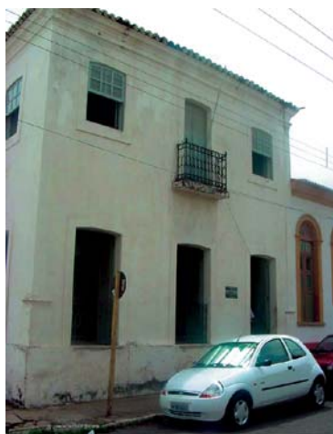
Figura C13 - Prédio do Museu Café Filho (O Sobradinho). Concluída em 1820, a construção é o único exemplar residencial, do período colonial, preservado em Natal. A partir de março de 1979, após restauração, suas dependências passaram a abrigar o Museu Café Filho, homenagem ao único potiguar a exercer a Presidência da República.
