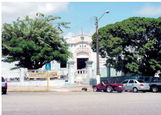
Figura C19 - Prédio do antigo Congresso Estadual. No local funciona, desde 1978, a Ordem dos Advogados do Brasil, seção do Rio Grande do Norte. Localizado no atual Largo Junqueira Aires, foi inaugurado em 14 de julho de 1906 para sediar o antigo Congresso Legislativo Estadual, precursor da Assembléia Legislativa.
