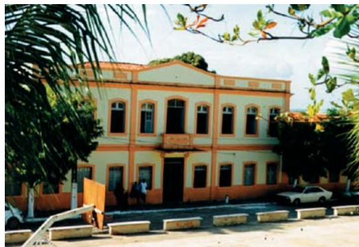
Figura C20 - Casa do Estudante de Natal. A edificação está situada na Praça Lins Caldas. Construído em 1856 para abrigar o Hospital de Caridade, a partir de 17 de setembro de 1914 o prédio recebeu a instalação do Batalhão Policial Militar. Em novembro de 1935, o prédio foi palco de intenso combate durante a chamada Intentona Comunista. Desde 22 de agosto de 1956, funciona no local a Casa do Estudante. (Foto: Esdras Rebouças Nobre).
