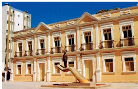
Figura C8 - Memorial Câmara Cascudo. Localizado na Praça André de Albuquerque, o prédio no qual funciona o Memorial foi concluído no início do século XIX. Nele funcionou o antigo Real Erário e, em 1817, André de Albuquerque instalou, no contexto da Revolução Pernambucana, seu efêmero governo republicano. Sua atual denominação é uma homenagem ao renomado intelectual potiguar. (Foto: Esdras Rebouças Nobre).
