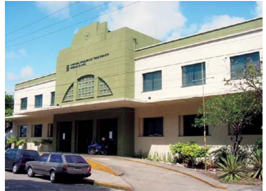
Figura R8 - Estação da Rede Ferroviária Federal (atual CBTU). Prédio no qual funcionou a antiga Great Western, estrada de ferro mantida pelos ingleses no início do século XX. Após término do contrato, foi encampada pelo Governo Federal.
