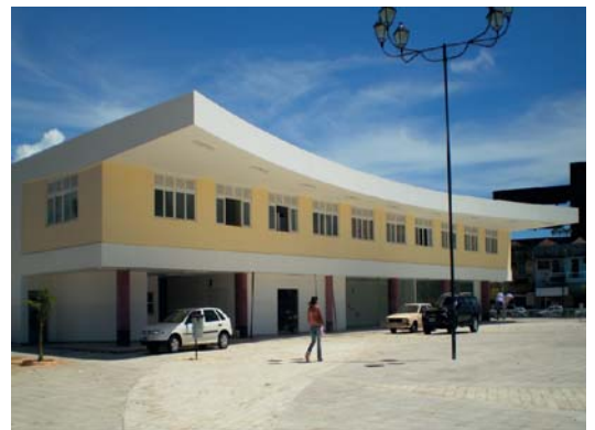
Figura R10 - Museu de cultura popular Djalma Maranhão. Instalado na antiga rodoviária Presidente John Kennedy, no bairro da Ribeira. Lugar ideal para uma casa da memória. Antes da rodoviária, construída em 1963, existia o Tabuleiro da Baiana, outrora tradicional reduto boêmio. É neste local, repleto de história, que encontramos o Museu de Cultura Popular Djalma Maranhão, com um vasto acervo do Patrimônio Material e Imaterial da Cultura Popular.
