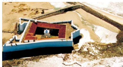
Figura N6 - Fortaleza dos Reis Magos. Sua construção foi iniciada em 6 de janeiro de 1598, dia consagrado no calendário cristão aos Santos Reis, daí a sua denominação. O projeto arquitetônico é atribuído ao padre Gaspar de Samperes e foi posteriormente aperfeiçoado pelo engenheiro Francisco Frias de Mesquita. Representa o principal monumento histórico do Rio Grande do Norte. (Foto: Esdras Rebouças Nobre).
