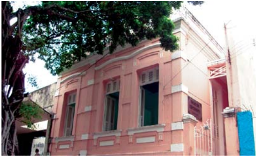
Figura C31 - Casa da Estudante. Esta edificação apresenta uma arquitetura eclética, datando sua construção, provavelmente de anos anteriores a 1926 (Folha de memória, março/abril-2003). O prédio abriga desde 1977 a casa da Estudante. Apresenta aspectos típicos das construções do início do século XX. Em 19/05/2004, foi Tombado como Patrimônio Histórico Estadual. Localiza-se no largo da Junqueira Aires, em pleno corredor cultural.
